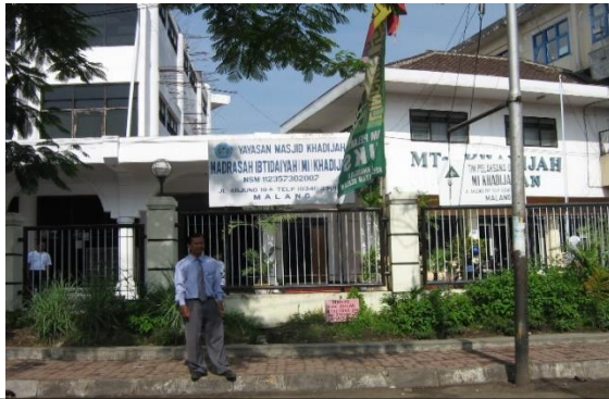
Gedung milik Yayasan Masjid Khodijah yang disewa untuk kegiatan belajar mengajar siswa-siswi MIN Malang 2
