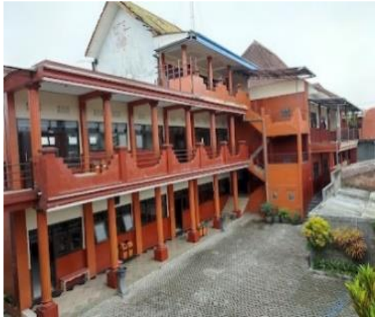
Bangunan MTs Islamiyah Sukopuro
