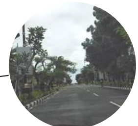
Jalan menuju Terminal penumpang (sisi timur)
