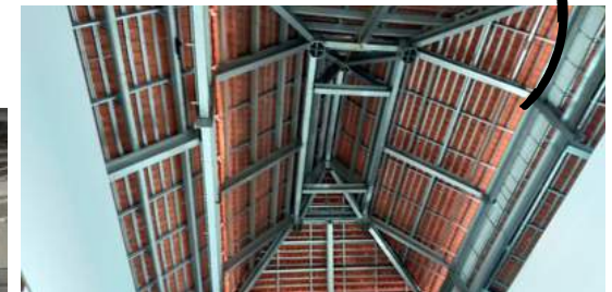
Detail Struktur Atap Terminal Penumpang (dokumentasi pribadi, 2022)
