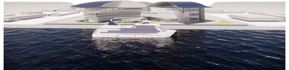
Bentuk bangunan mengalami perubahan pada atap nya.
