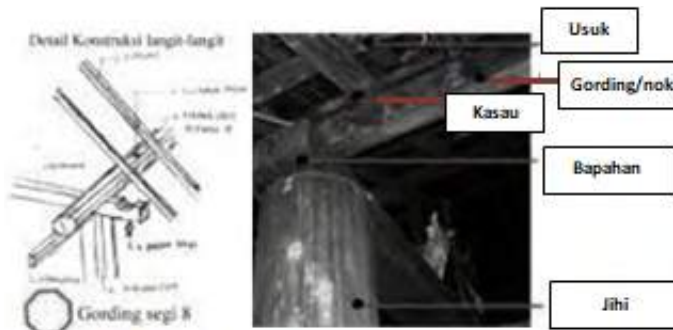
Gambar 2.66 Struktur Atap Rumah Betang Dulu (Sumber : Depdikbud 1997/1998)
