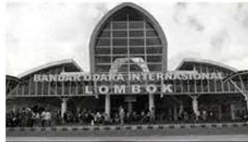
Gambar 2.88 Bentuk Bandar Udara Internasional Lombok (Sumber : https://lombok-airport.co.id/ )
