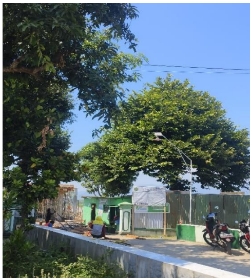
KUA Balong (proses renovasi)
