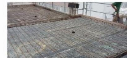
Struktur atap musholla menggunakan atap dak beton.
