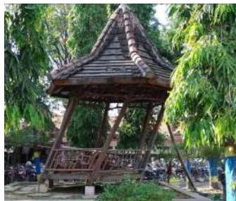
KONDISI BANGUNAN DAN FASILITAS TIDAK TERAWAT
