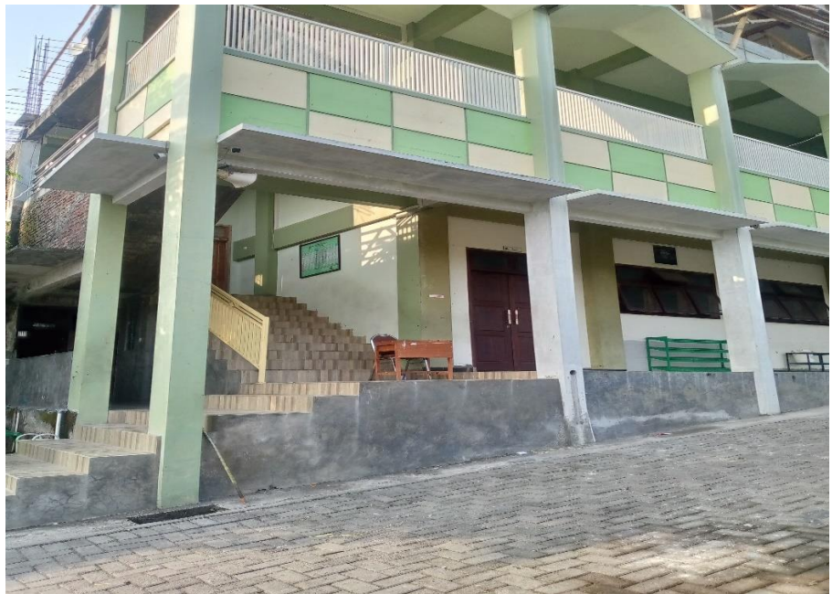
Gambar 8 Gedung Sekolah MTs. Ma'arif Sukorejo
