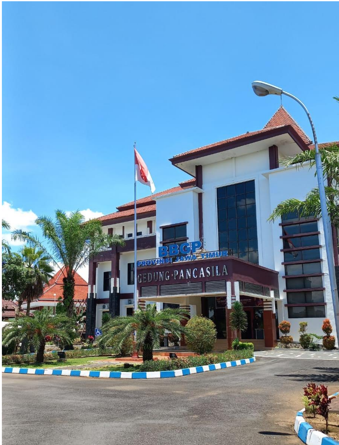
Gedung BBGP Jatim
