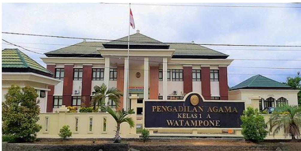
Gambar 4. 2 Gedung Baru Pengadilan Agama Watampone
