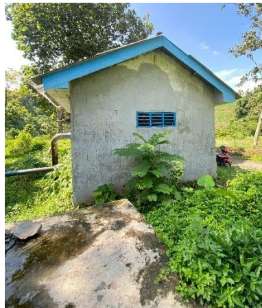
Gambar 4. 5 Rumah Pompa PDAM
