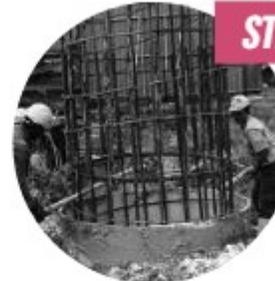
Pondasi strauss ini menggunakan cairan beton yang cukup padat. Dengan demikian, hasilnya pun akan lebih kokoh dan kuat. Selain itu, pondasi ini berdiri pada lapisan tanah yang dalam, sehingga tidak akan terjadi banyak retakan.
