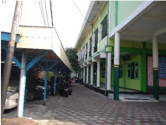
Tampak Belakang Gedung Pendidikan Terpadu (Program SBSN Tahap 1 dan 2 Tahun 2018/2019)
