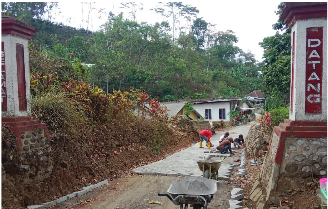
Salah satu proyek pembangunan jalan ( Paving ) di Dusun Gunung Gunitir
