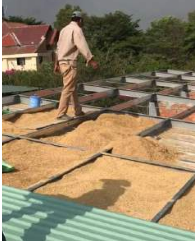
Gambar 41. Atap Insulasi Panas dengan material Gabah Sumber:
