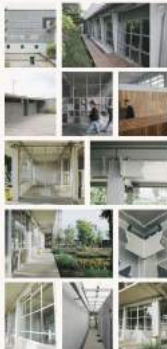
Gambar 4. Struktur dan Bangunan Modular Sumber: rumahatsiri.com ; https://rumahatsiri.com/about
