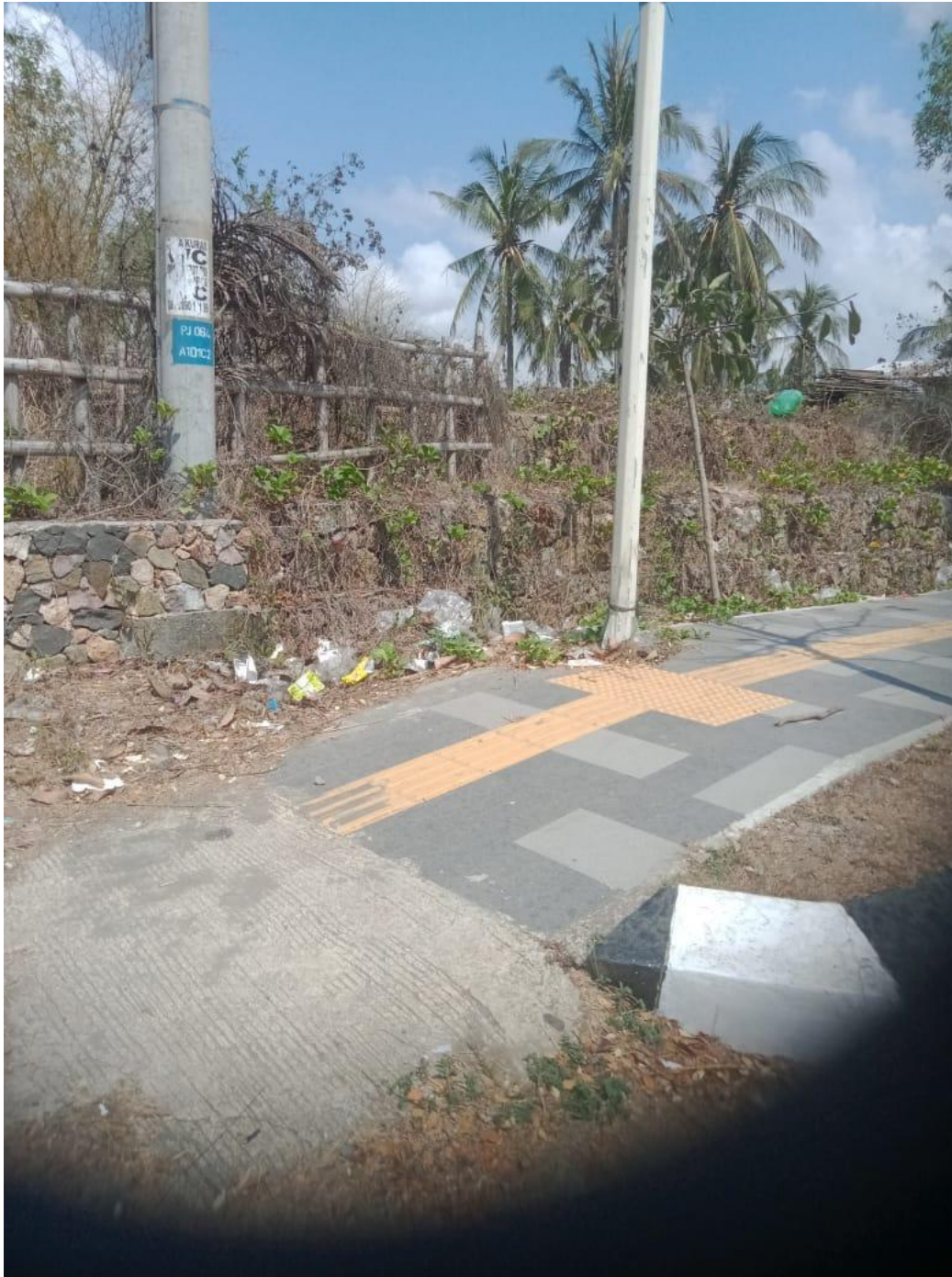
(Kondisi Sepanjang Jalan Mandalika Lombok Tengah )
