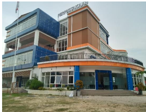
Gambar 4.1 Gedung Perpustakaan Kabupaten Blora (Sumber: Dokumen Peneliti, 2023)
