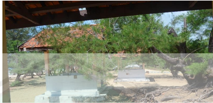
Gambar 4.2 fasilitas gazebo tidak terawat (sumber : Dokumen Pribadi, 2015)
