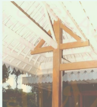
Gambar 2.18 Sistem Rangka Bangunan Pesantren Pabelan
