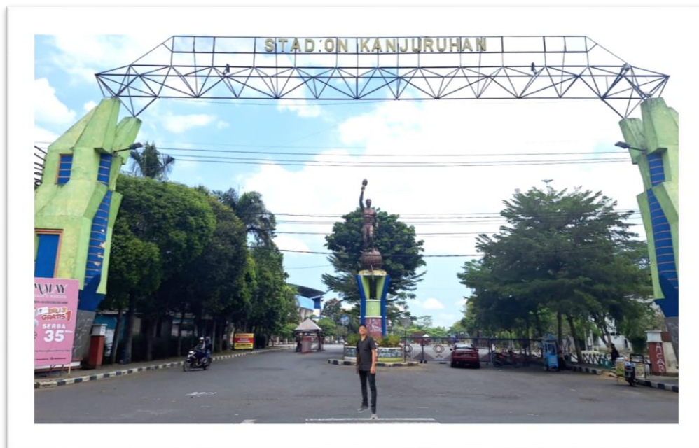
Gambar 2.4 Pintu Utama masuk Stadion Kanjuruhan
