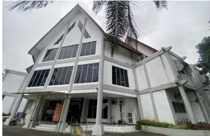
Gambar 4.1: Gedung Dinas Perpustakaan Umum dan Arsip Daerah Kota Malang (Sumber: Dokumentasi Peneliti, 2023)
