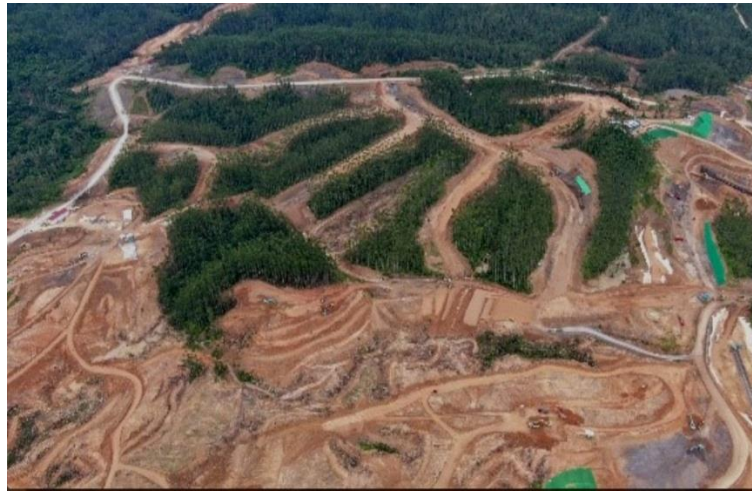
Gambar 3.4 Pembukaan lahan untuk pembangunan IKN
