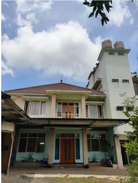
Foto Pondok Tampak Depan
