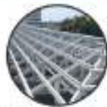
Rangka Baja (Truss) Penggunaan truss pada atap sebagai elemen upper-structure untuk menahan beban angin lateral.
