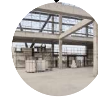
Balok dan kolom
