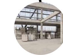
Balok dan kolom
