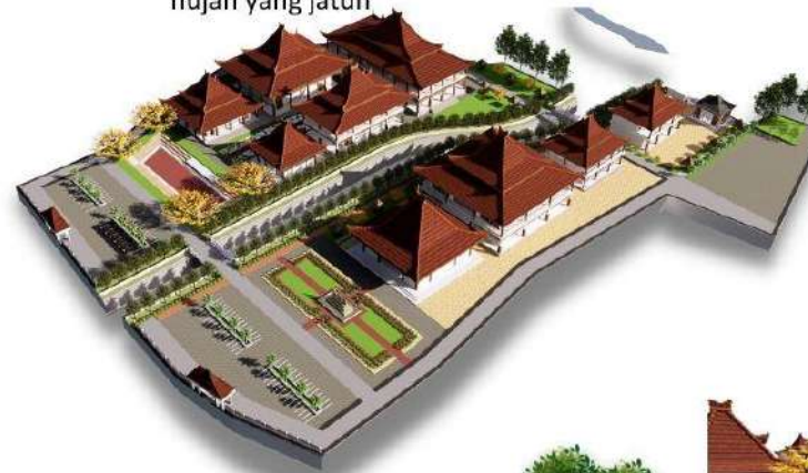
Bentuk atap yang miring memudahkahn untuk air hujan yang jatuh
