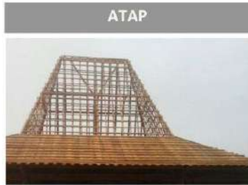
Gambar. Kerangka Atap Kayu
