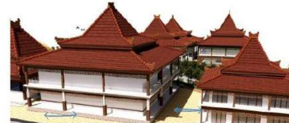
Peletakan Jarak bangun yang berfungsi untuk memudahkan sirkulasi udara
