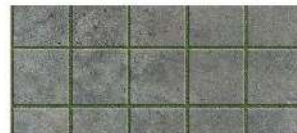
Penggunaan Material paving grass agar air hujan masih bisa meresap ke tanah
