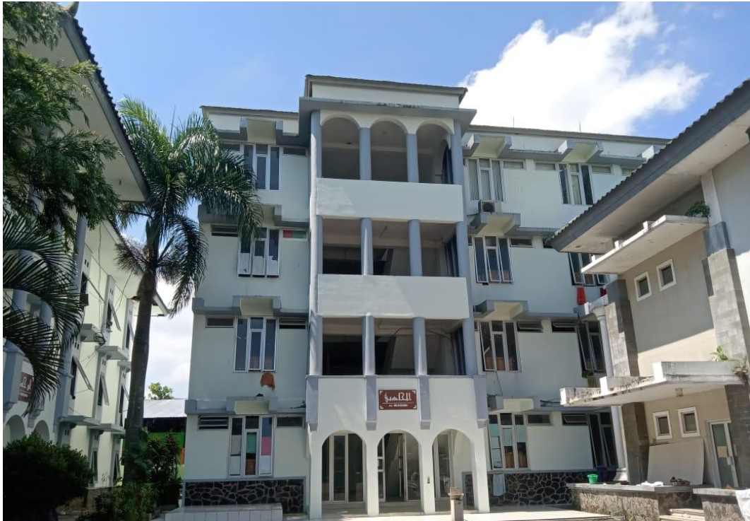
Dokumentasi Gedung Ma'had Putra
