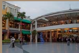
Gambar 23. Fasad Cilandak Town Square Sumber: Epicentrum.co.id
