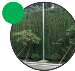
LEE KUAN YEW Diletakkan pada dinding pembatas tapak sebagai peredam suara.
