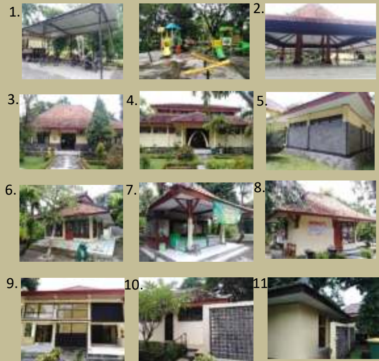
Gambar 1.15 bangunan eksisting Sumber: Survei, 2021
