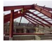
Rangka baja WF
