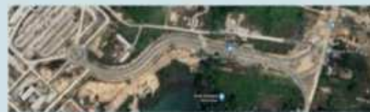
Aksesibilitas jalan proyek bandara dengan lebar 6 meter.
