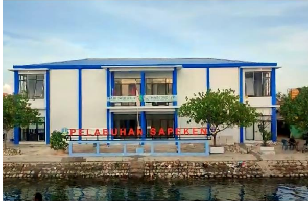
Gambar 1 Pelabuhan Baru Kecamatan Sapeken
