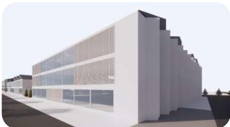
Wiremesh yang digunakan pada sisi timur bangunan menggunakan wiremesh dengan celah kecil.
