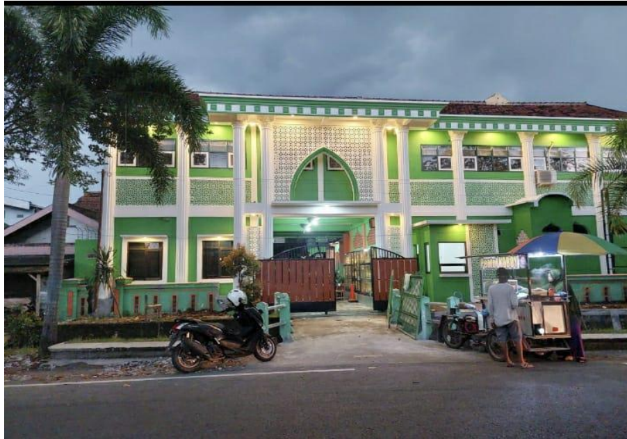
Gedung MAN 4 Madiun tampak depan
