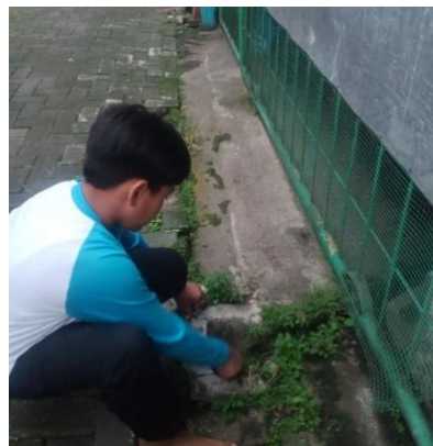
Gambar 4.15. Membersihkan Saluran Air
