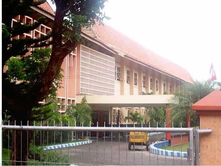
Foto 3. Gedung SMA Negeri 8 Malang Tampak Dari Samping
