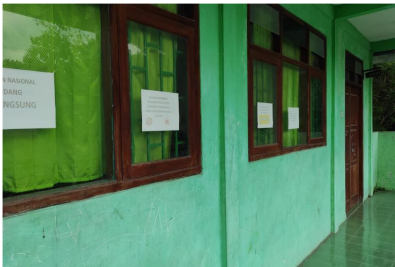
15. Ruang Laboratorium Komputer
