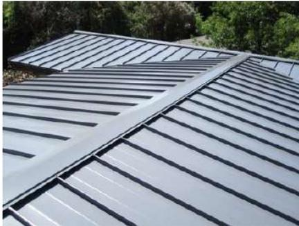
menggunakan jenis atap plana, pada struktur digunakan sistem struktur rangka dengan material kayu prefabrikasi juga dan menggunakan penutup atap zinalume karena memiliki bobot yang ringan, tahan suhu dan cuaca serta dapat memantulkan panas
