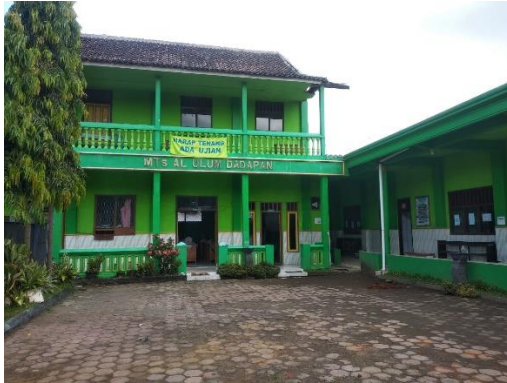
Gedung MTs Al-Ulum
