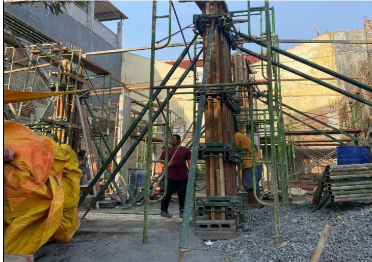
Proyek pembangunan CV. Mutiara Indonusa
