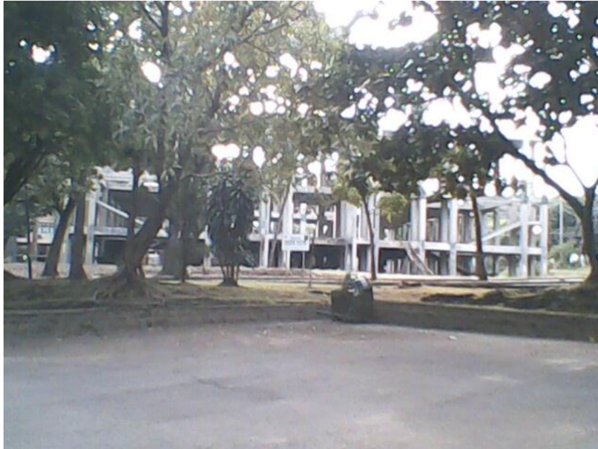
Masjid Raden Patah baru yang masih dalam proses pembangunan
