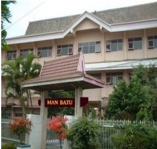
Gambar 1 : Gedung Sekolah MAN Malang II Batu tampak dari depan
