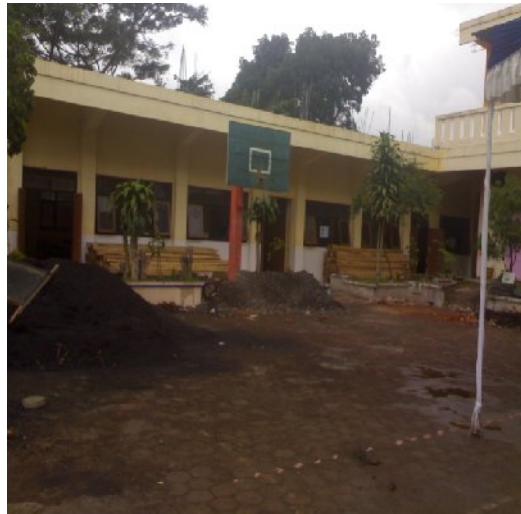
Gambar 2 : Kondisi MAN Malang II Batu tampak dari dalam, dalam taraf pembangunan
