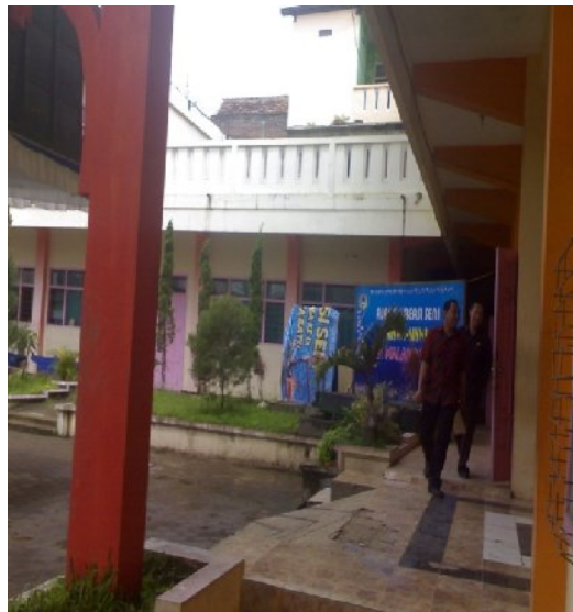
Gambar 4 : Kondisi MAN Malang II Batu saat terlihat dari samping
