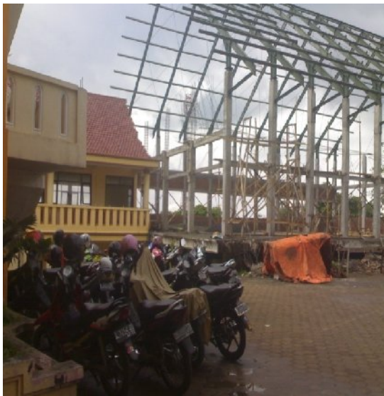
Gambar 3 : Kondisi MAN Malang II Batu tampak gedung yang direnofasi
