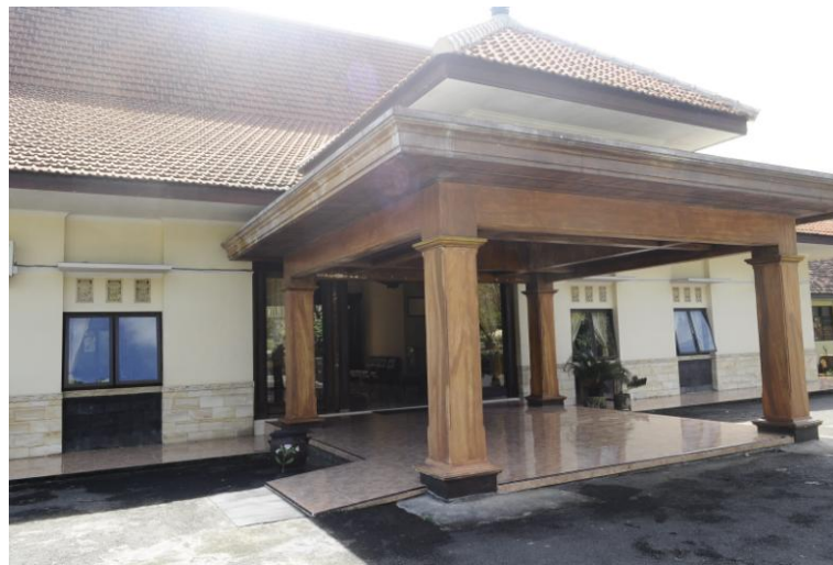
Gambar 8: Kantor Guru SLB Pembina Tingkat Nasional Bagian C Malang
