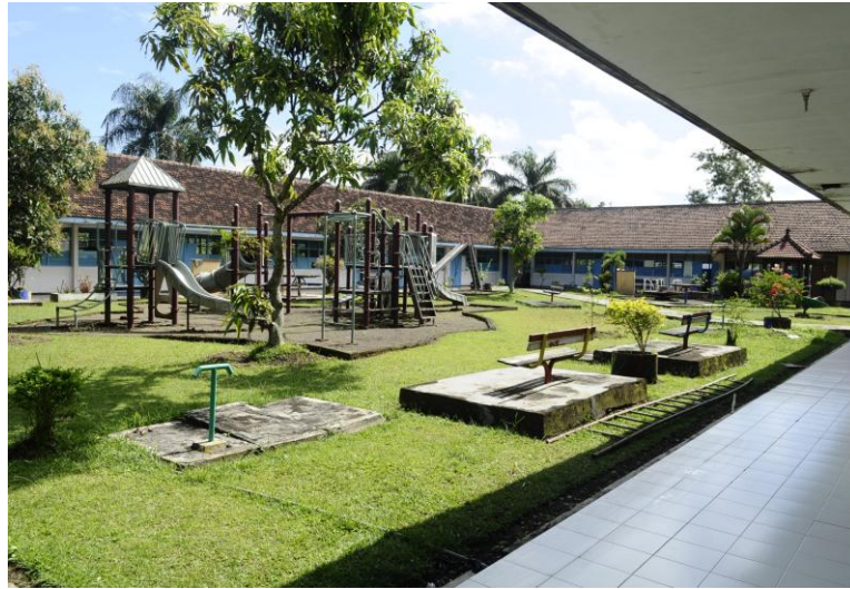
Gambar 9: Ruang Kelas SLB Pembina Tingkat Nasional Bagian C Malang
