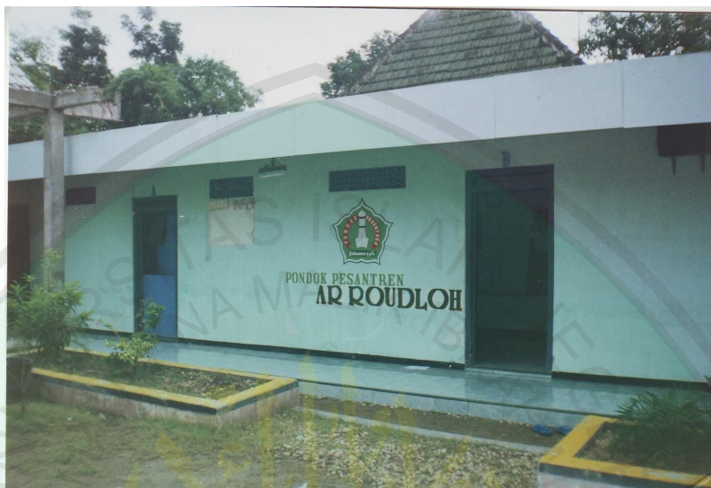
Bangunan Pondok Pesantren AR-ROUDLOH Tampak dari Depan
