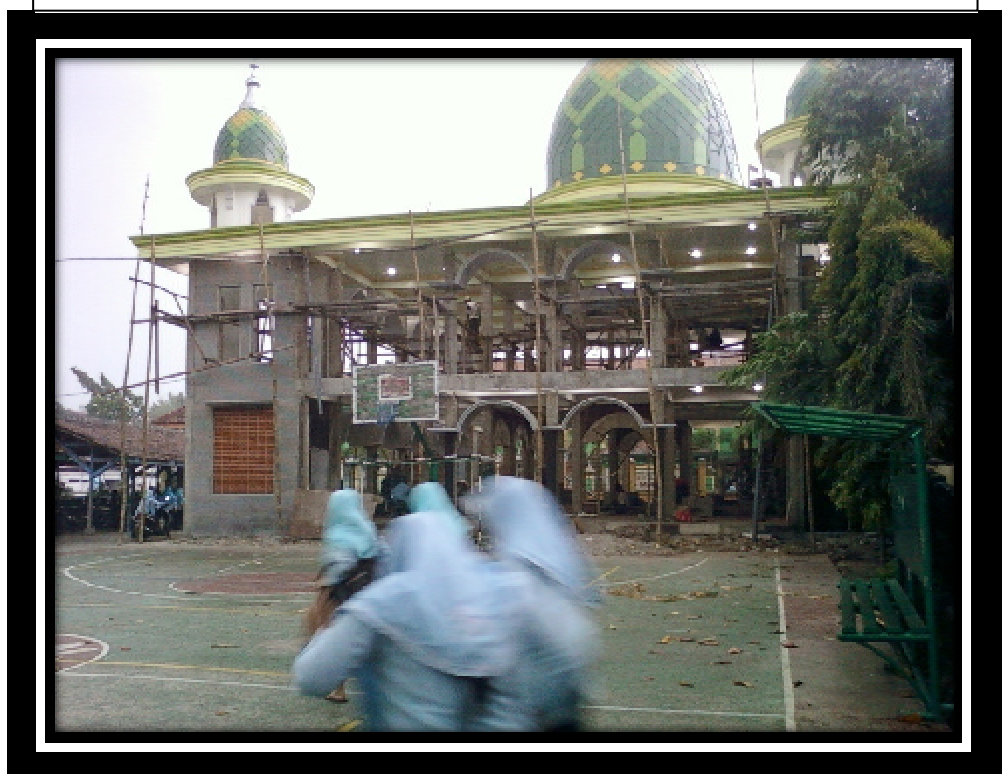
Pembangunan masjid MAN Tambakberas di lapangan kampus 2
