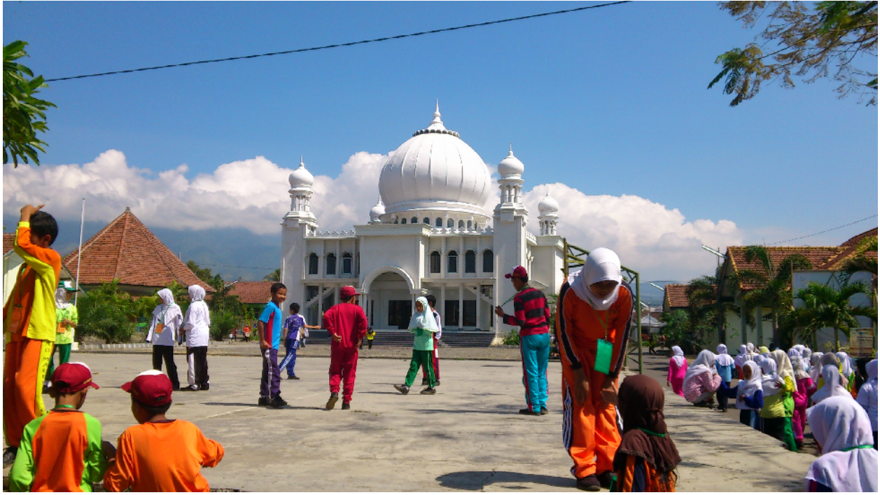
Bangunan Masjid MTs Negeri Batu
