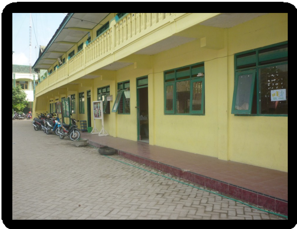
Kantor guru, ruang perpustakaan dan ruang kelas I int dan II int
