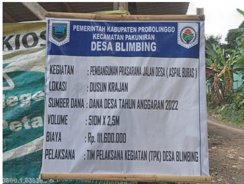
Gambar 19 Pelaksanaan Aspal Buras Jalan Desa
