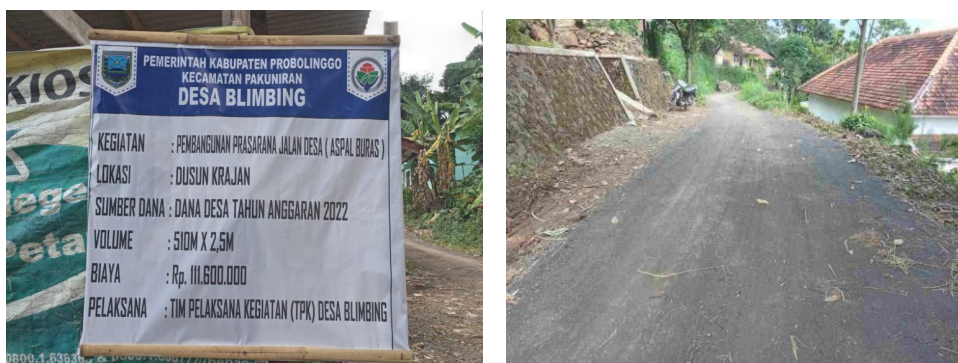
Gambar 16 Pembangunan Aspal Jalan Desa
