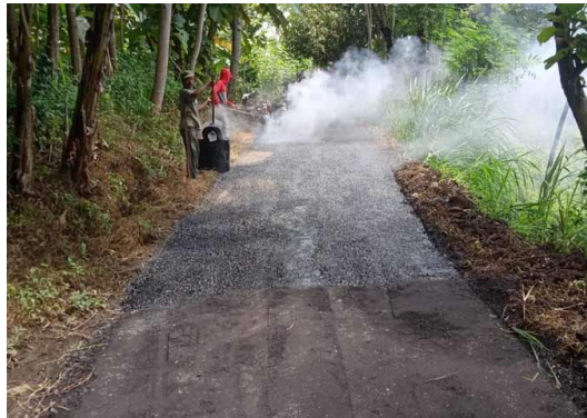
Gambar 12 Jalan tembus antar dusun
