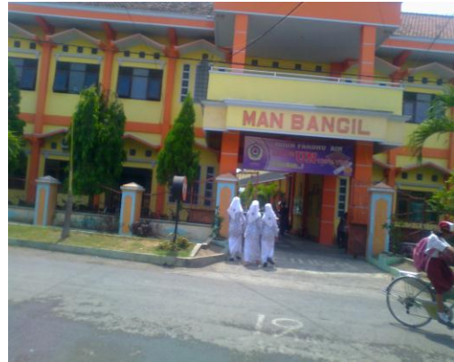
Gambar gedung sekolah diambil dari depan
